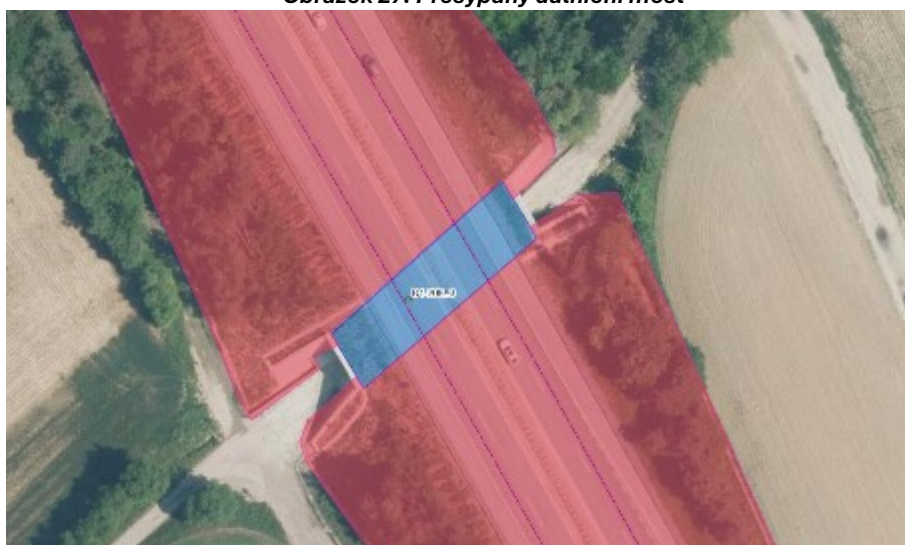
Obrázek 27: Přesypaný dálniční most
