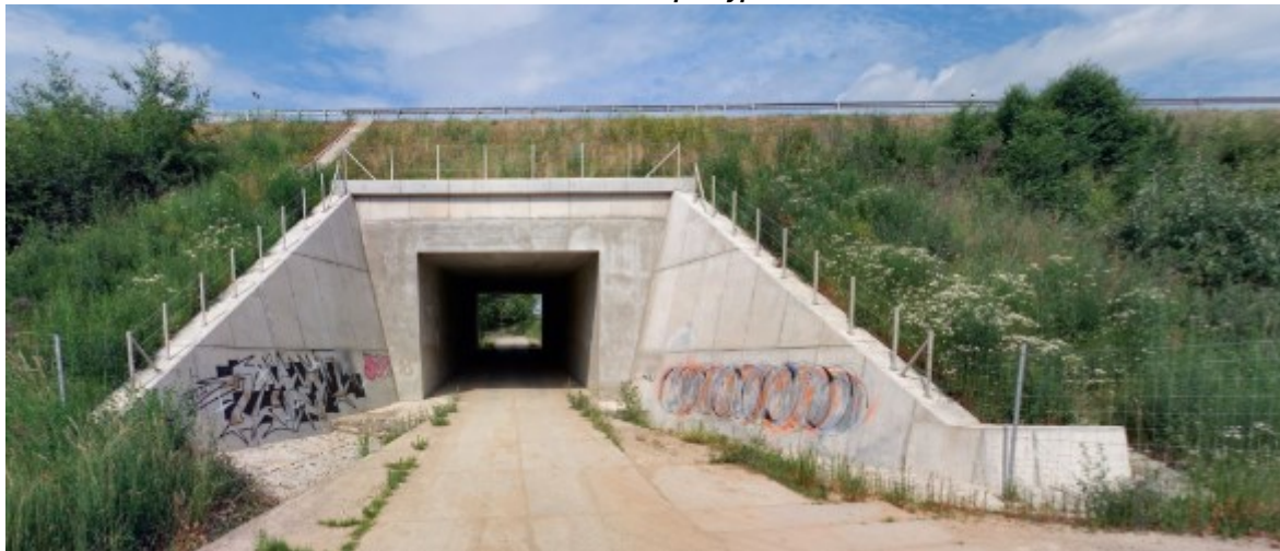
Obrázek 26: Ukázka přesypaného mostu
